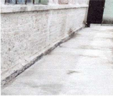
Foto 1: Paredes durante el repello
