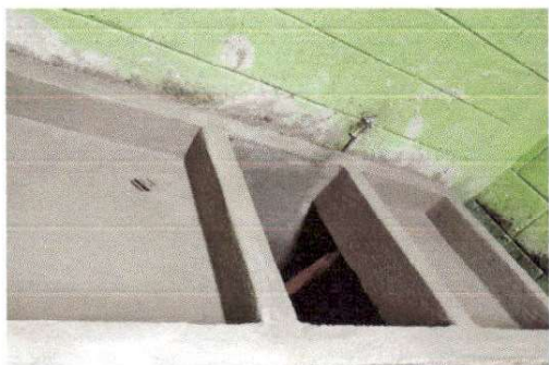
Foto 3: Construcción de la pila de la cocina
