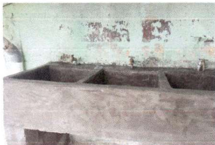
Foto 1: Construcción de lavamanos
