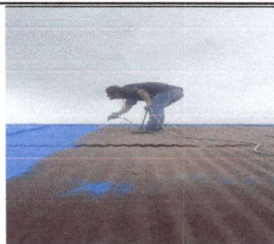
Foto 4: Pintando el techo
