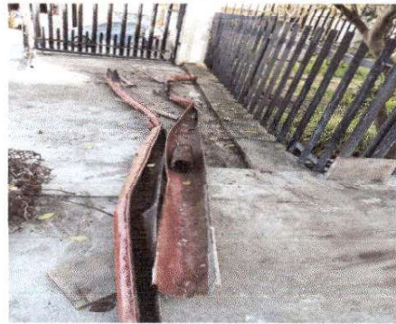
Foto 4: Cambio de canales y bajadas de agua
