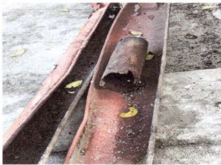
Foto 3: Cambio de canales y bajadas de agua
