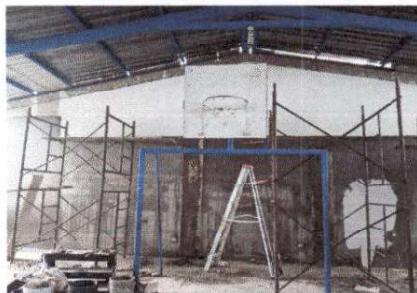
Foto 2: Remozamiento del fondo de la cancha polideportiva
